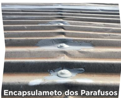
Encapsulamento dos Parafusos
