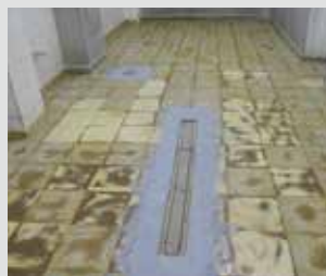
Reforço de grelhas
