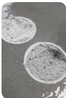
Teste de Arrancamento sobre base de concreto = 46 a 50 Kgf/cm 2
