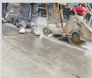
Corte para abertura da junta
