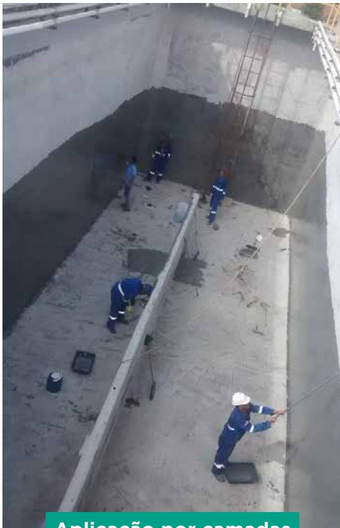
Aplicação por camadas
