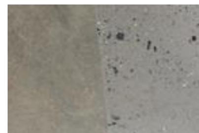
A preparação do substrato deve ser executada por meios mecânicos, com politriz e cubos diamantados, para gerar a abertura de porosidade da superfície e criar um perfil de ancoragem para receber a aplicação.
