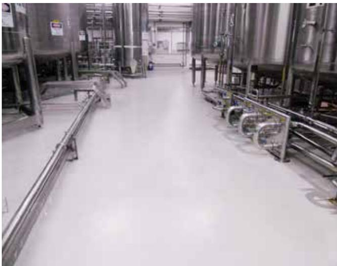
Um sistema de revestimentos monolíticos composto por quartzos pigmentados na granulometria e cor desejada que, depois de aplicados no piso, são protegidos por camadas de resina incolor, resultando em um piso com padrão estético de elevada sofisticação, além de excelente resistência mecânica e abrasiva.
