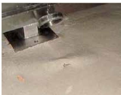
Bolhas, decorrentes de umidade ascendente da base ou presença de agentes contaminantes como: xarope, açúcar, óleos e gorduras, ao serem estouradas, conterão líquido. Bolhas secas indicam alguma falha na aderência, que precisará ser analisada para entender aonde a ruptura ocorreu. Em caso de bolhas, deve ser agendada visita técnica para análise da causa e encaminhamento da solução, que poderá ou não estar coberta na garantia.
