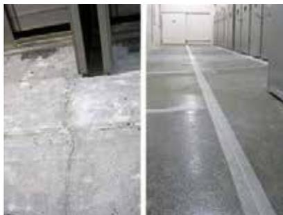
Elevadas movimentações estruturais podem causar trincas e fissuras em revestimentos monolíticos. Para minimizar estes problemas, as áreas de risco ou juntas, podem ser tratadas com a aplicação do tecido estruturante e resinas com flexibilidades diferenciadas. Em caso de impermeabilizações, pela flexibilidade diferenciada de nossos sistemas, as trincas podem marcar as camadas de acabamento (mais rígidas), não afetando as integridade do sistema e, neste caso, não precisam de reparos.
