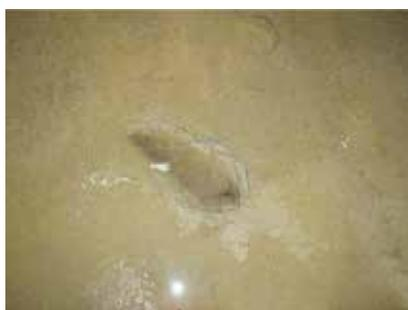
Fortes esforços mecânicos pontuais como: queda, arrastes ou agressões desproporcionais à resistência do sistema (descritas no Boletim Técnico de cada sistema ou produto), podem causar ruptura do mesmo e perda de sua integridade. A partir desta ruptura, ocorrerá infiltração de líquidos que podem gerar problemas de deslocamentos no revestimento.
