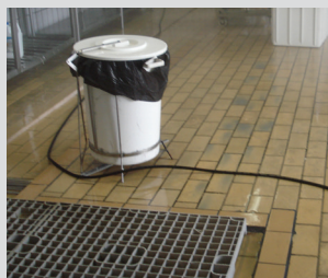
Antes da instalação
