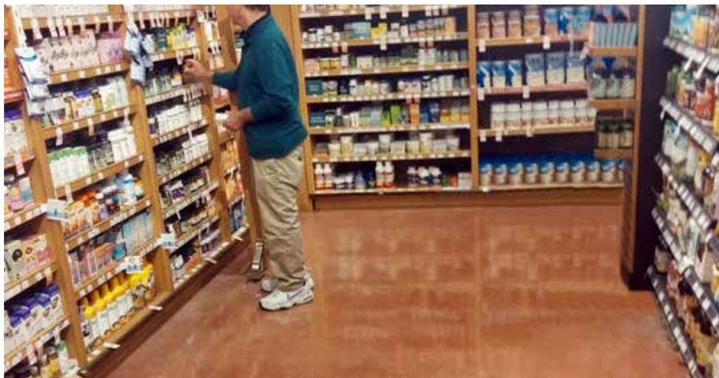
Essa reação resulta em cores desuniformes, elegantes, profundas e duráveis, transformando o simples concreto em um ambiente diferenciado. Cada superfície de concreto aceita o manchamento em diferentes graus de intensidade, criando variações de cores e uma superfície irregular com tom de envelhecido.
